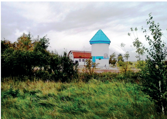
Рисунок 4 – Надкаптажное здание на скважине №5492-Э, 2018 г.
